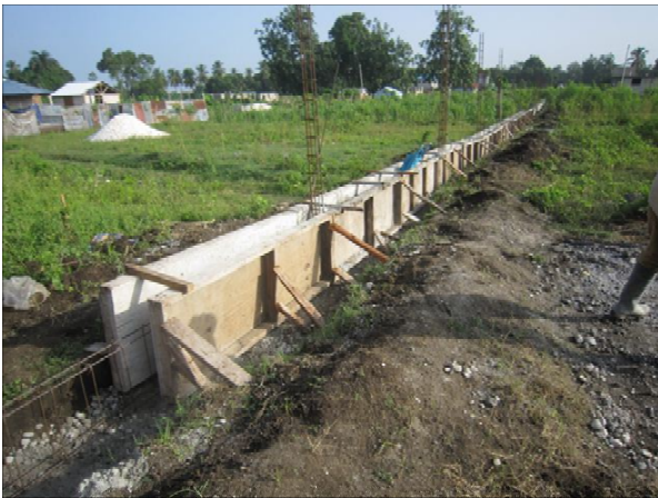
▲農業学校建設予定地
