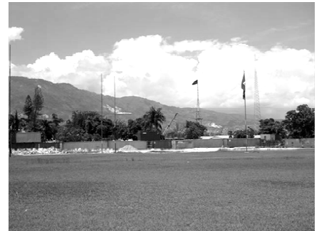
▲ 解体された大統領府
